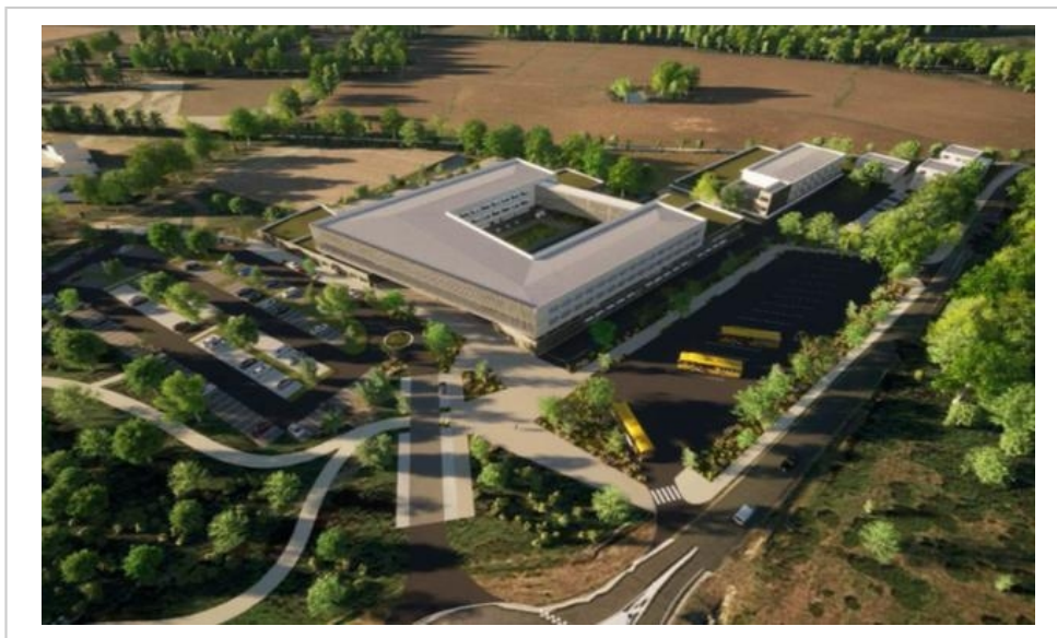
Vue aérienne du futur lycée qui ouvrira en 2026. Il pourra, à terme, accueillir jusqu'à 1 500 élèves. « Le végétal sera omniprésent », décrit l'architecte, Christian Collard, du cabinet nantais Forma6. © @ Forma6
